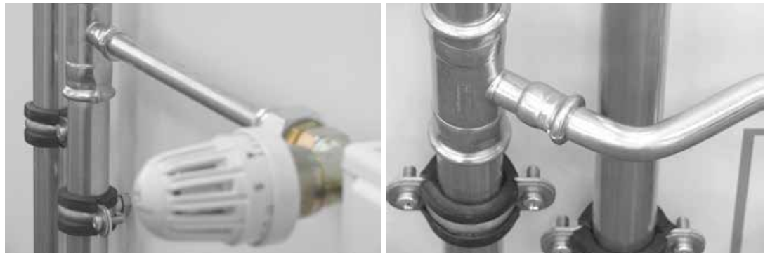
Pripojenie radiátora (napájacia a spätná vetva) v systéme KAN-therm Steel
